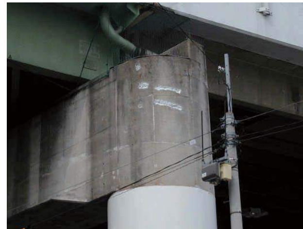
コンクリート剥落量計測
