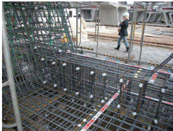
鉄骨間隔計測
