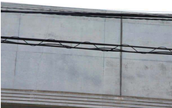
橋梁コンクリート板計測
