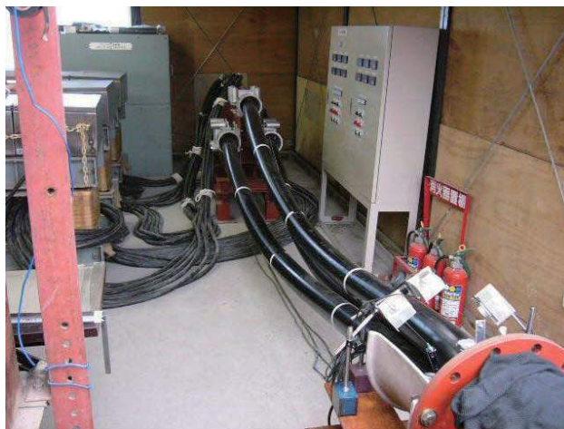
ケーブル長、ケーブル間計測
