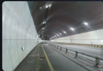
インフラ設備
